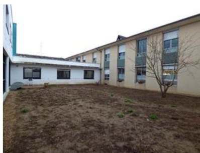
Espace du patio avant transformation
